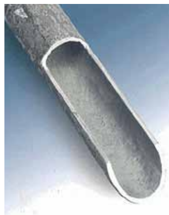
2. saubere Trinkwasserleitung nach der Reinigung
