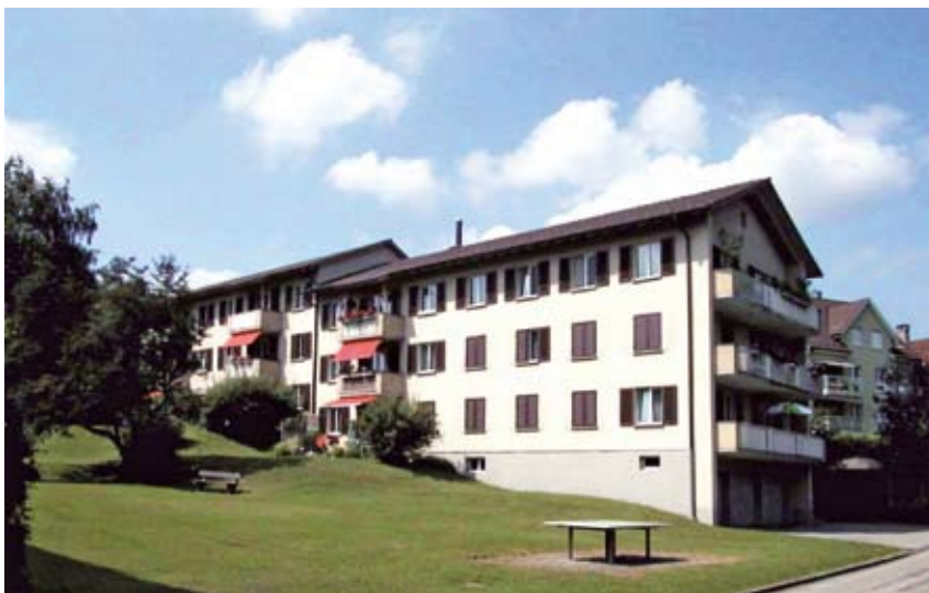
Die Liegenschaft Kolumbanstrasse 56/58 vor der Sanierung
