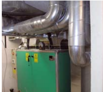
Neue Lüftungszentrale im Kellergeschoss der Liegenschaft
