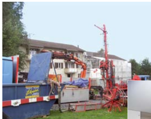
Bohrung für Erdwärmesonde zwischen den Liegenschaften Kolumbanstrasse 56/58 und Kolumbanstrasse 52/54
