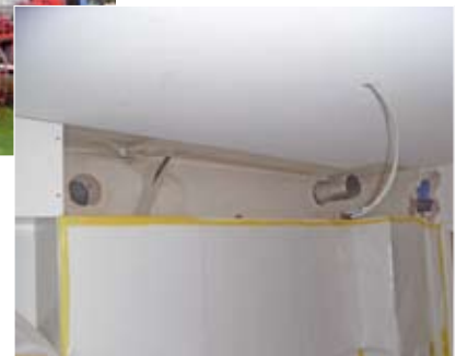
Zu- und Abluft im Blendenbereich der Küche
