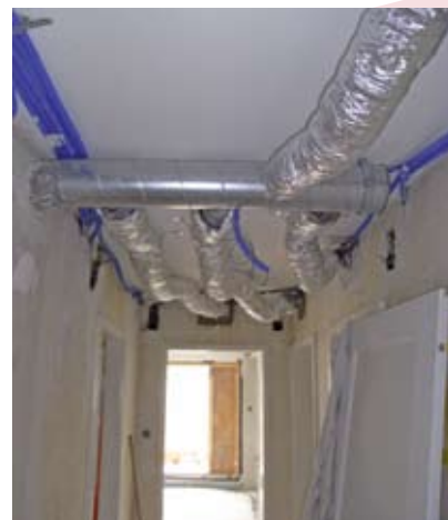
Einbau Lüftungsrohre zu jedem Zimmer im Korridor / werden später mit heruntergehängter Decke verdeckt
