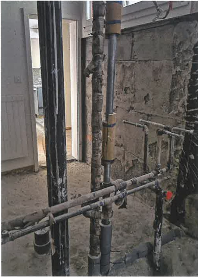
Sanierung des Leitungsnetzes
