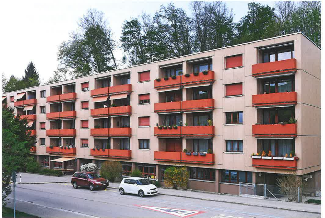
Liegenschaft St. Georgenstrasse 215 vor der Sanierung
